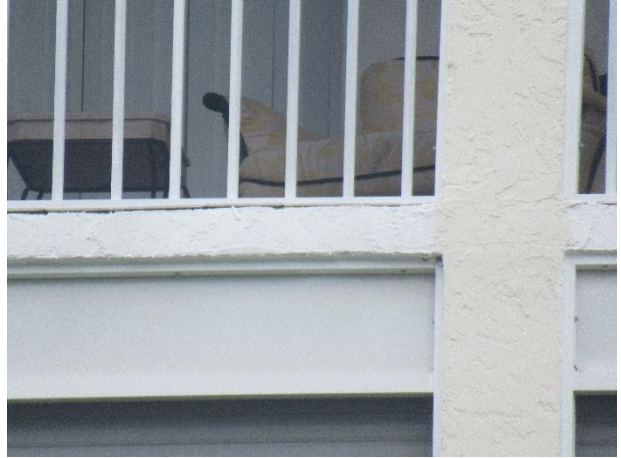
Balcony edge overview
